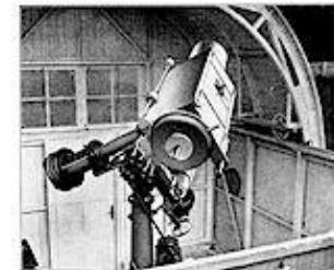
Komafreie Spiegelteleskop 1:1.75 der Hamburger Sternwarte in Bergedorf
